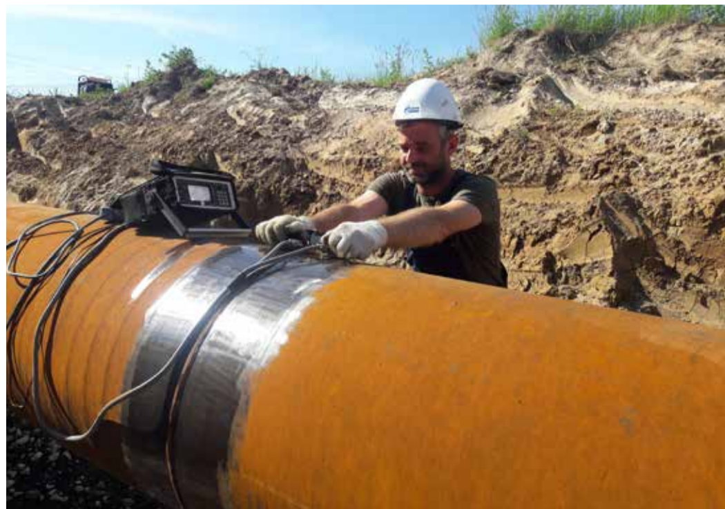
Специалисты ИТЦ выполняют ультразвуковой контроль качества сварных швов
