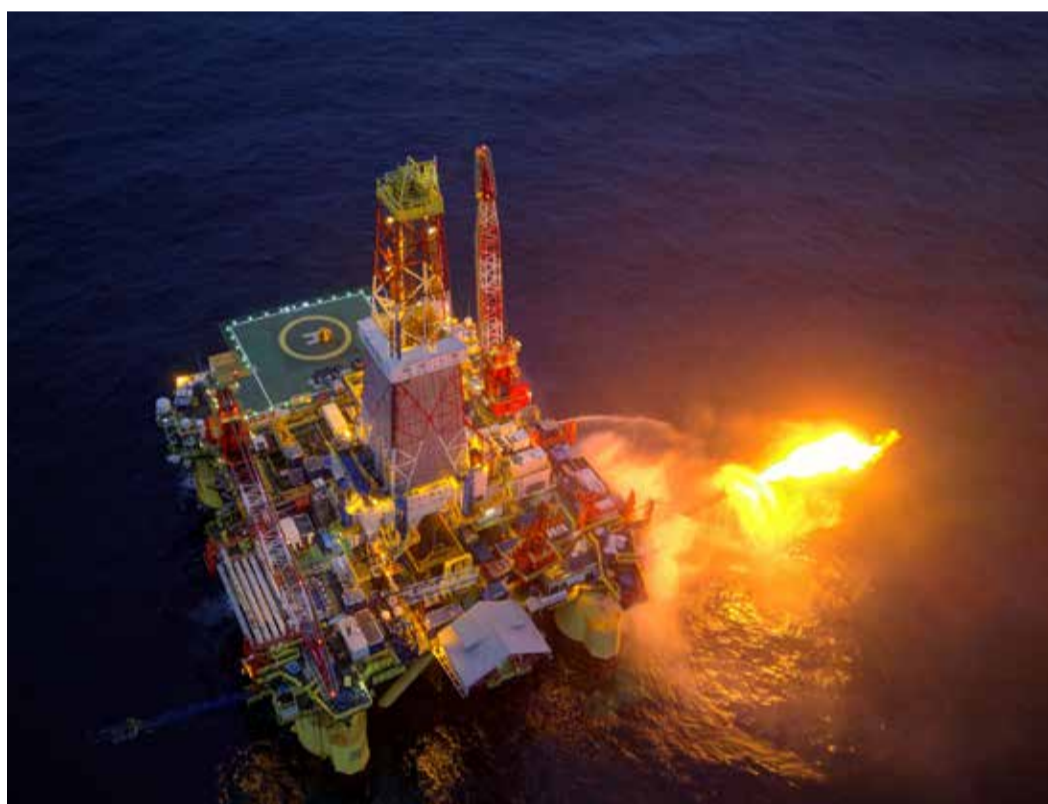
Испытание скважины на Русановском лицензионном участке в Карском море
