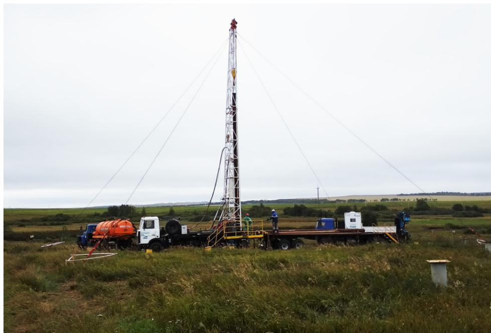
Специалисты Башкирского УАВР и КРС проводят капитальный ремонт анодного заземлителя
