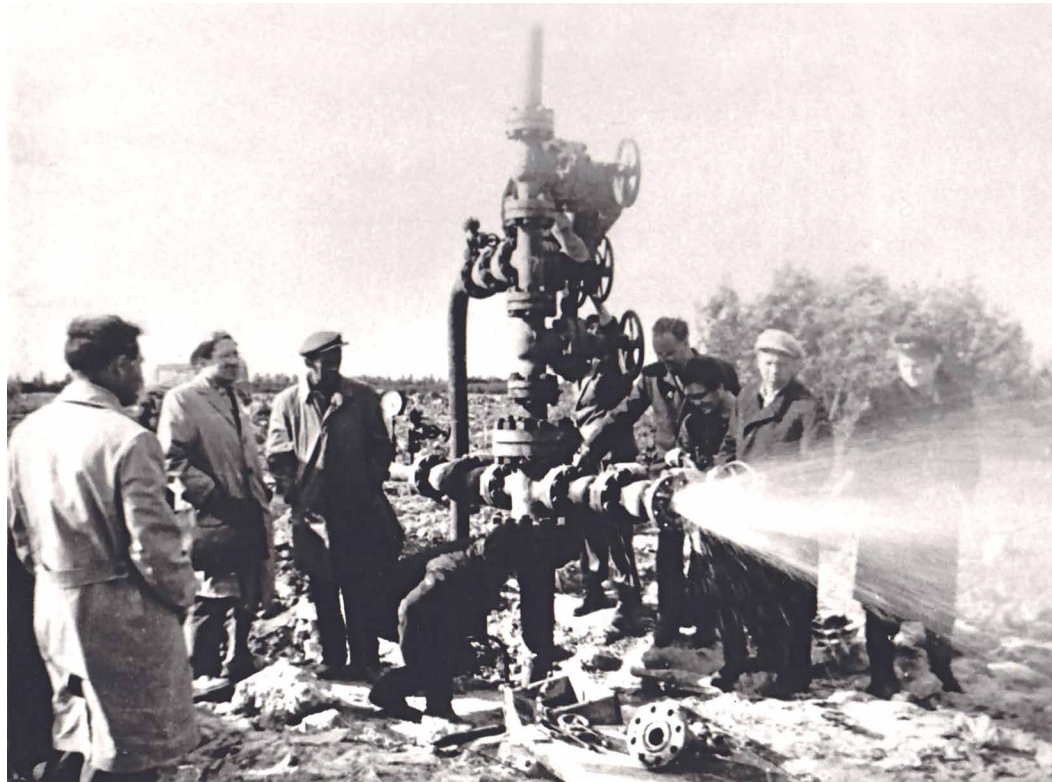
Работы по исследованию дебита скважины при пробном отборе воздуха на Гатчинской площади, 1961 г.
