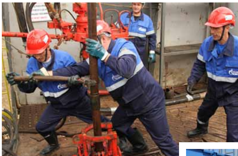
Работа бригады капитального ремонта скважин
