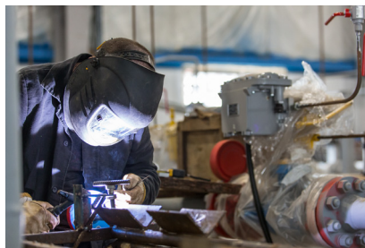
Строительство сборного пункта газа № 1
