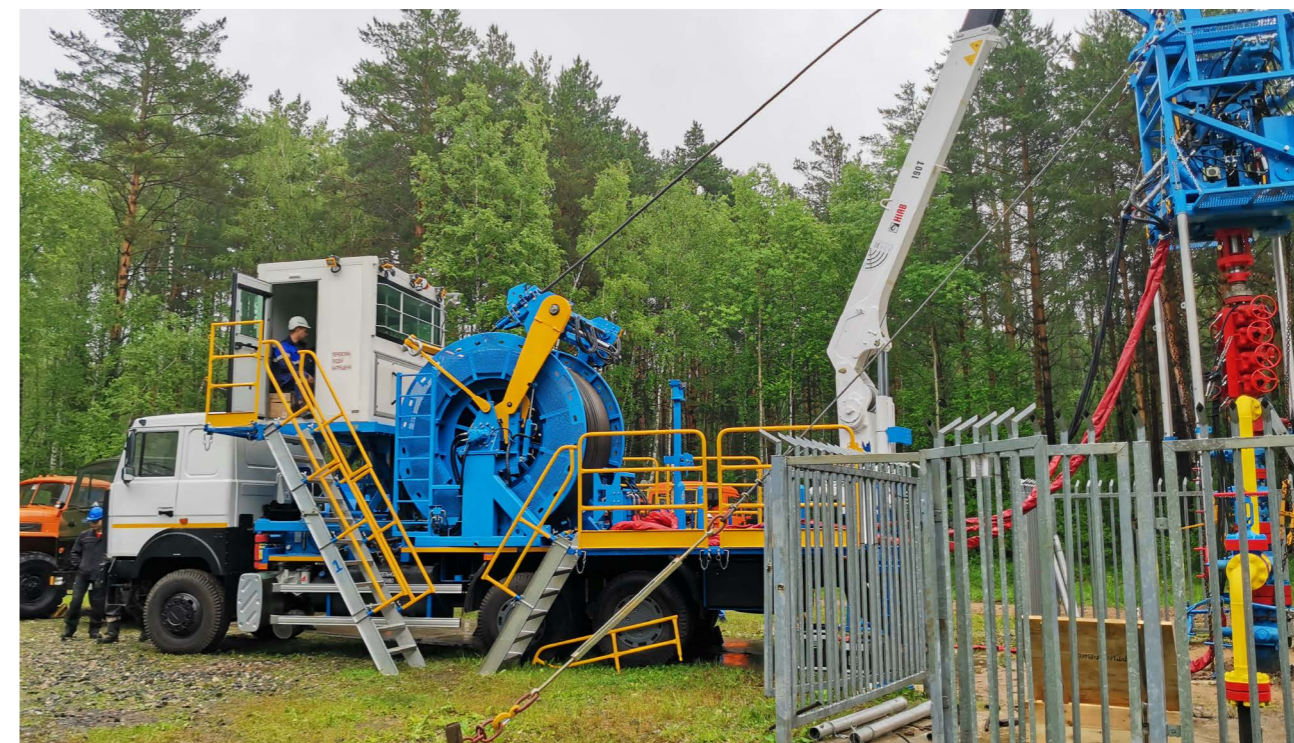
ФОТО 2. Апробация колтюбинговой установки УНТ-1 на скважинах Калужского ПХГ
