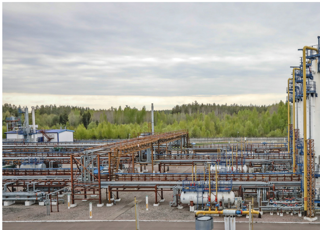
Установка осушки газа. Ее функция – окончательная очистка и осушка газа перед подачей в магистральные газопроводы
