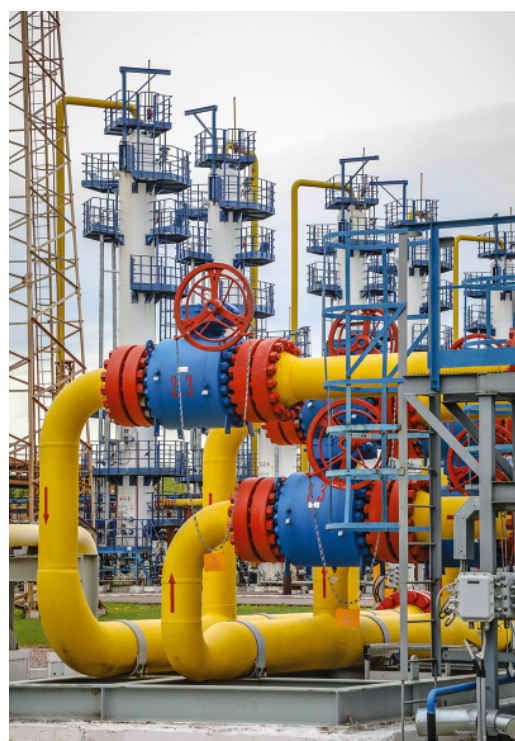
Технологическая обвязка фильтров-коагуляторов, очищающих газ от механических примесей и масла перед подачей на сборные пункты и далее в скважины
