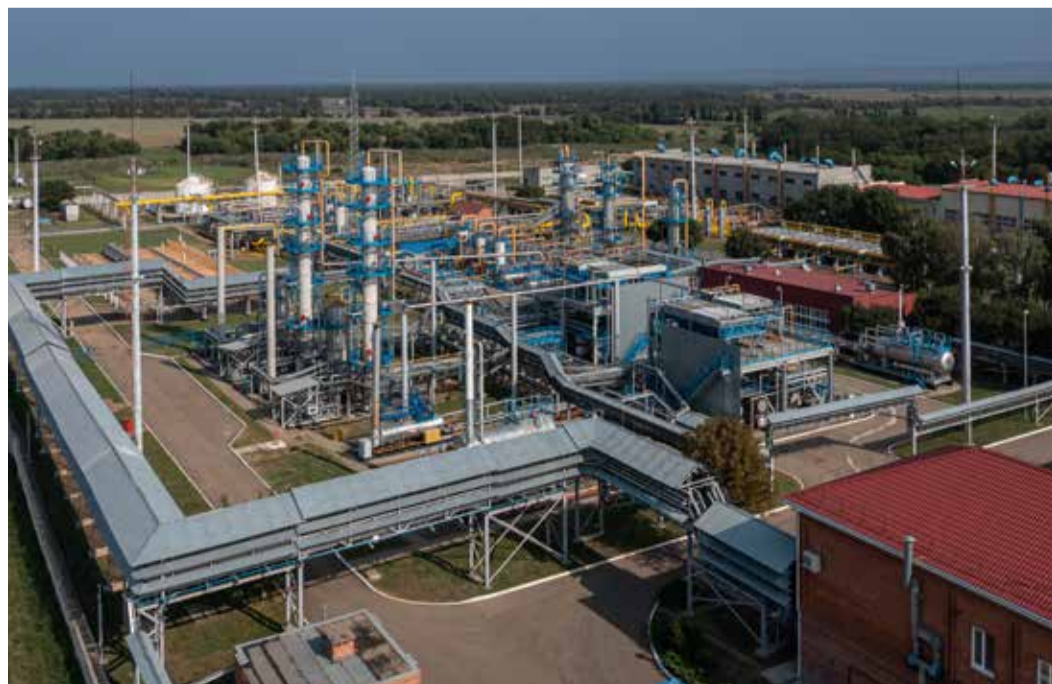
Производственная площадка Краснодарского УПХГ сегодня
