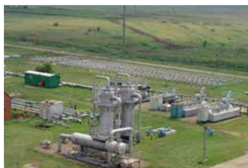
Обвязка пылеуловителей головных сооружений филиала до реконструкции
