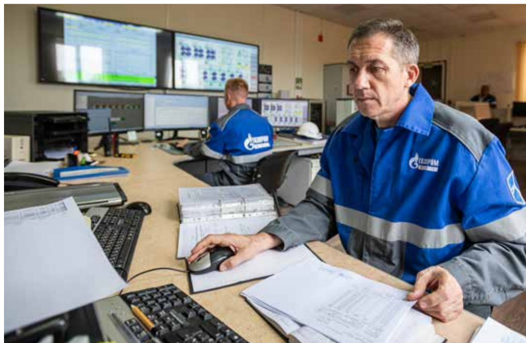
Благодаря проведенной реконструкции достигнут высокий уровень автоматизации производства
